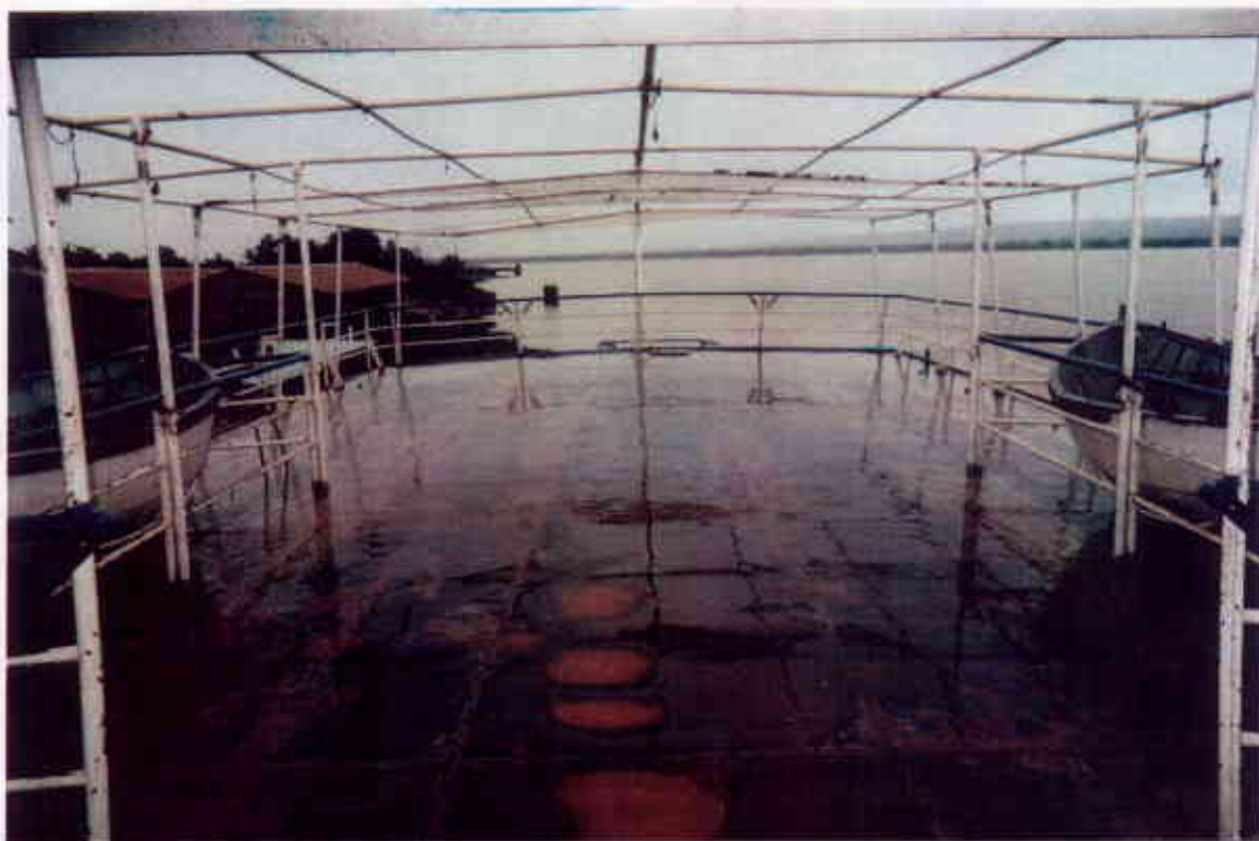
PONT PROMENADE 3 ème NIVEAU
