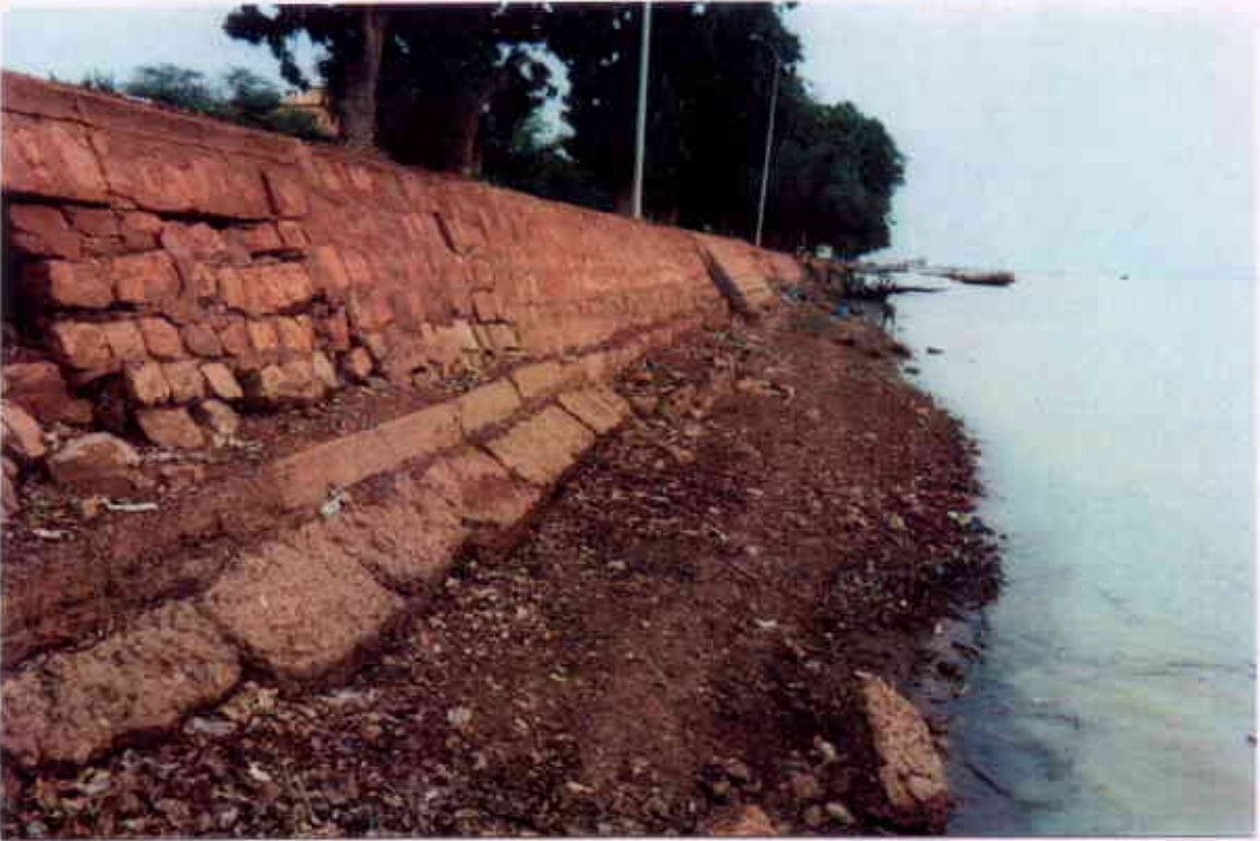
BERGE STABILISEE PAR MOELLONS DE PIERRES NATURELLES CIMENTEES
