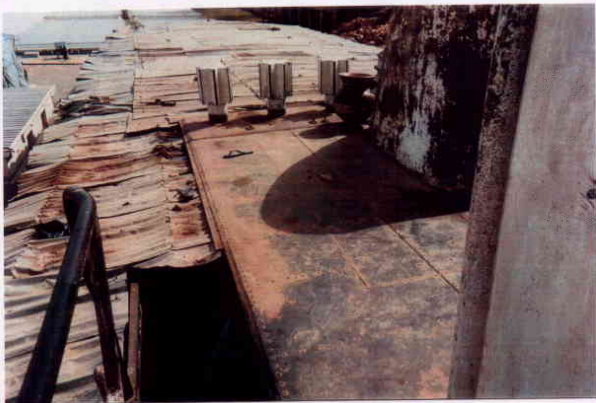
2 ème NIVEAU DE PONT : COUVERTURE PONT ARRIERE EN TOLES ZINGUEES
