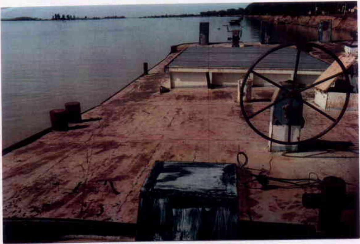
VUE D'ENSEMBLE DU PONT
