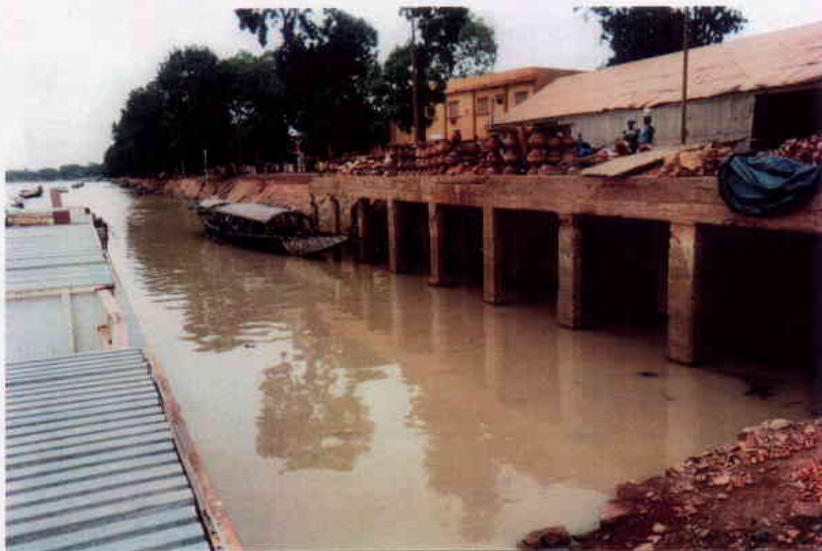
QUAI SUR PILIERS BETON
