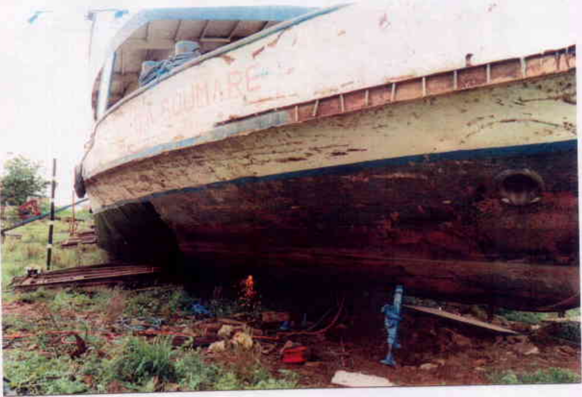
LOCAUX EQUIPAGE TRIBORD AVANT : TRAVAUX DE DECOUPE TOLE DE FOND
