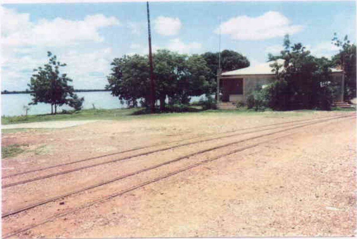
TERRE PLEIN DE LA COMANAV – VUE DES BUREAUX
